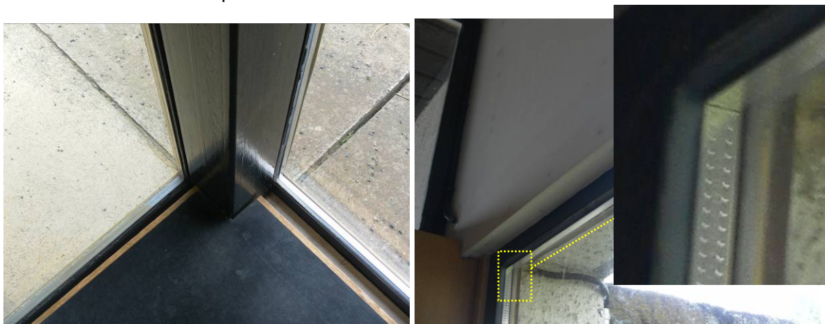
Kuva 16. Etujulkisivulla osa lämpölaselementeistä oli uusittu.
