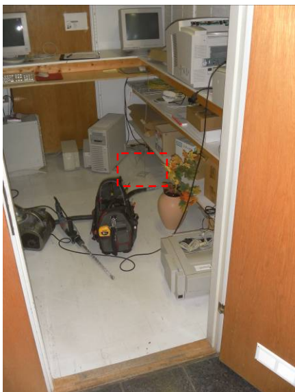
Kuva 4. Materiaalinäyte N2 otettiin välipohjan Toja-levyeristeestä havaitun kattovuodon alapuolelta. Näytteessä ei todettu aktiivista kasvua.
