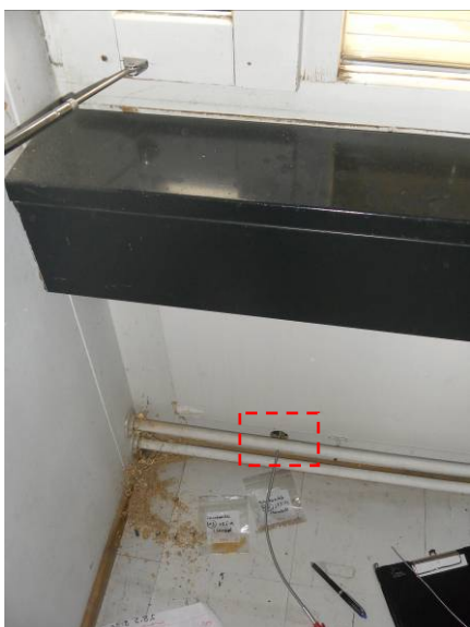
Kuva 5. Materiaalinäytteet N3 ja N4 otettiin ulkoseinärakenteesta satunnaisesti valitusta kohdasta. Näyte N3 otettiin lastulevyn takana olevasta 50 mm lasivillakerroksesta ja näyte N4 otettiin ulkopuolisen betoniseinän valumuottina olleesta Toja-levystä. Molemmissa näytteissä todettiin kohtalaista tai runsasta kosteusvauriota indikoivan ja mahdollisina toksiinien tuottajina pidettyjen aktinomykeettien (sädesienet) sekä homesienten kasvua. Näytteet osoittivat ulkoseinärakenteessa olevan selvästi viitearvot ylittävää mikrobikasvua.
