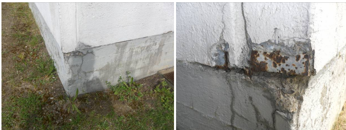
Kuva 12. Valtuustosali julkisivut oli tehty betonisista kuorielementeistä.
